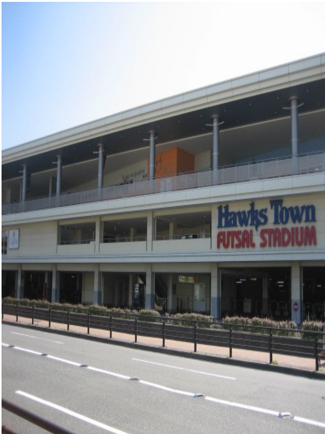
ホークスタウン第2モール 増築工事
