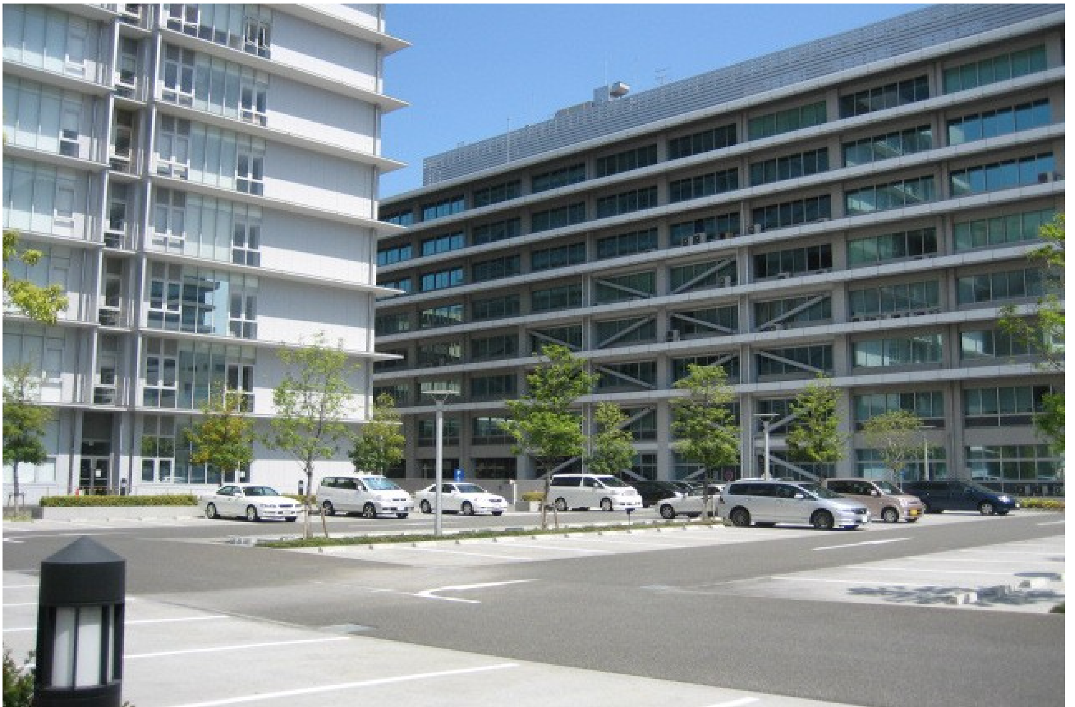
福岡第1合同庁舎 改修工事
