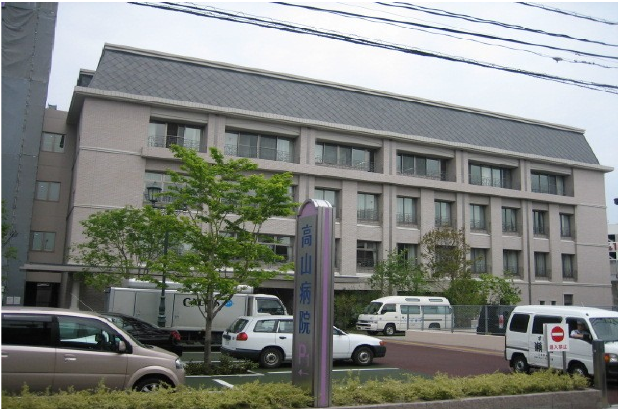
高山病院増改築工事
