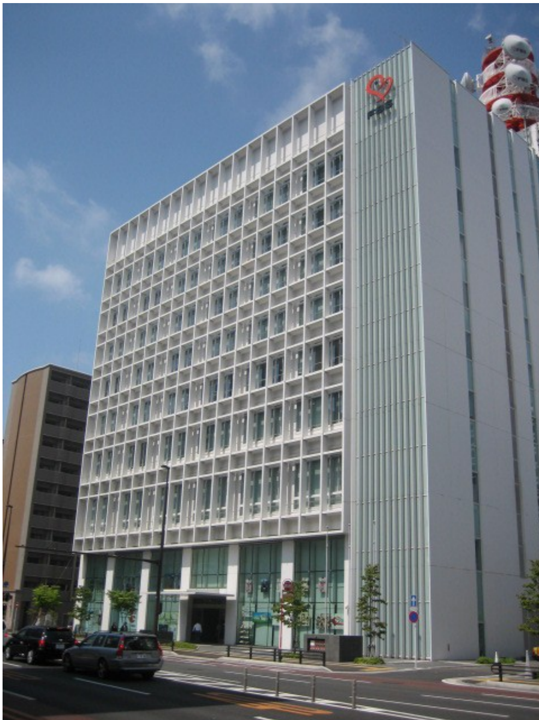
FBS福岡放送新社屋 新築工事
